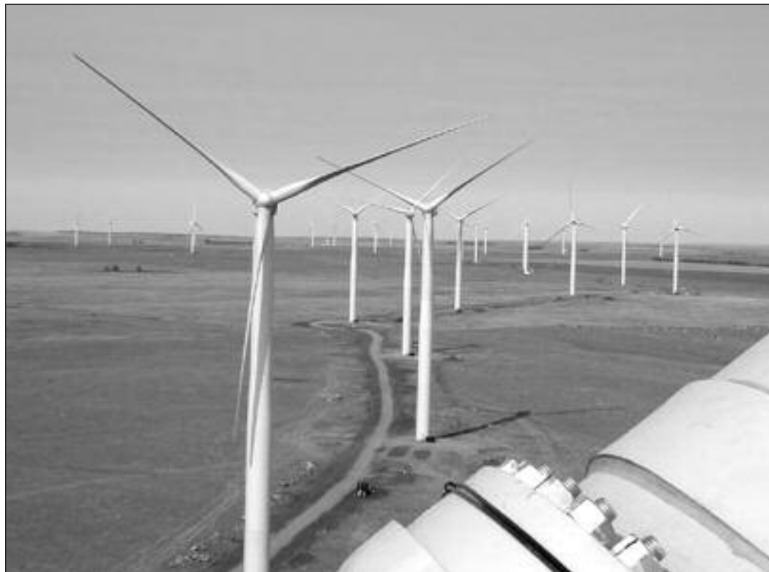
Bientôt dans un champ près de chez vous ? Parc d'éoliennes du type GE 1.5 MW en milieu agricole Gracieuseté du Groupe SM International inc.
